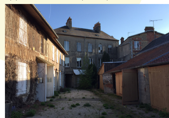
Vue intérieure de l'immeuble à réhabiliter
