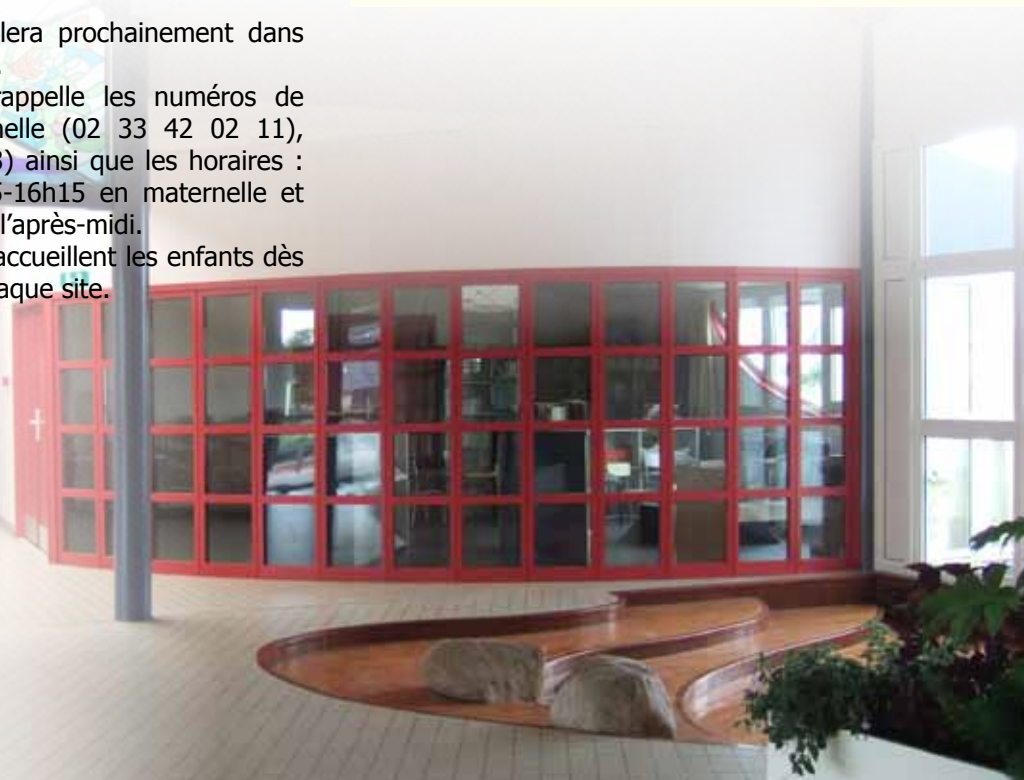
Travaux réalisés dans le hall d'entrée de l'école des Roseaux
