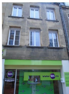
Illustration 2: façade rue du château
